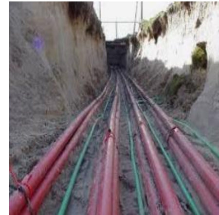
De onderwereld van kabels en leidingen
